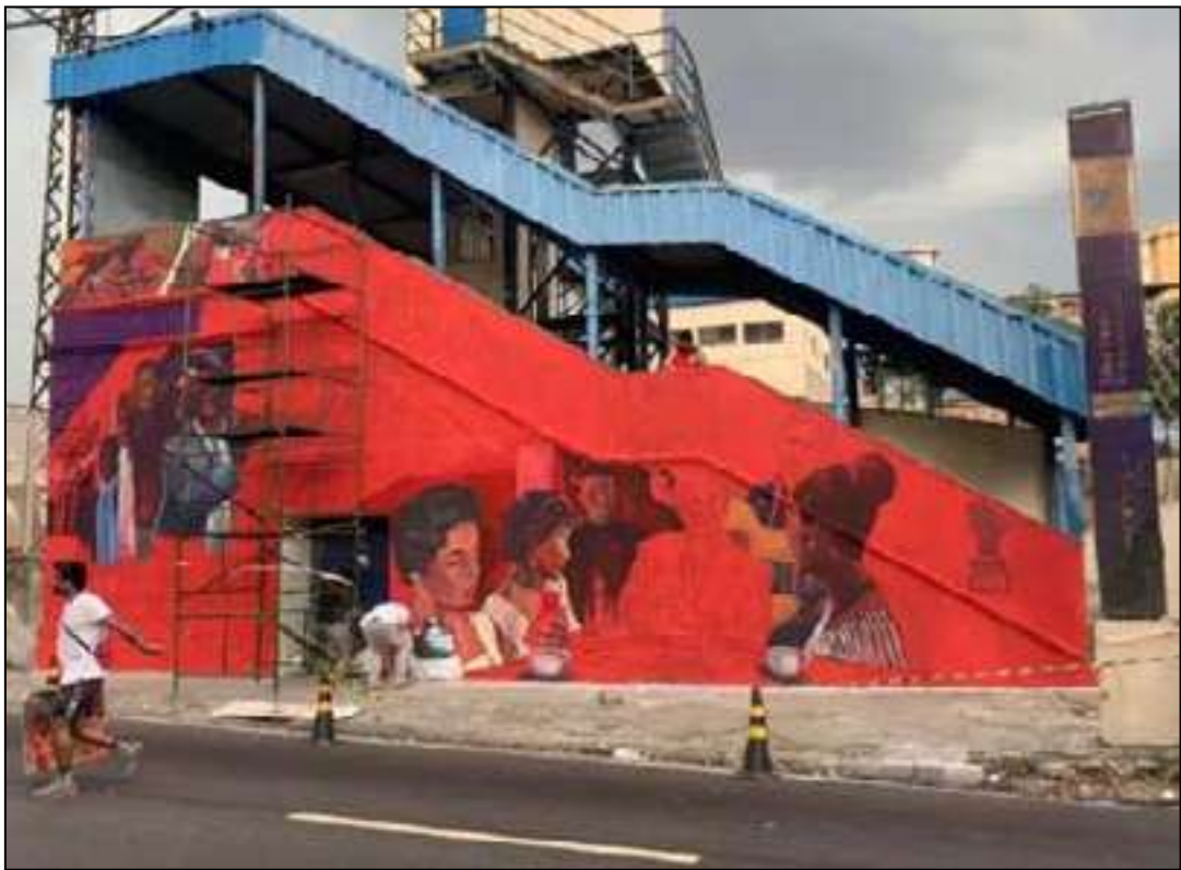
.Obra está na fase final de execução
