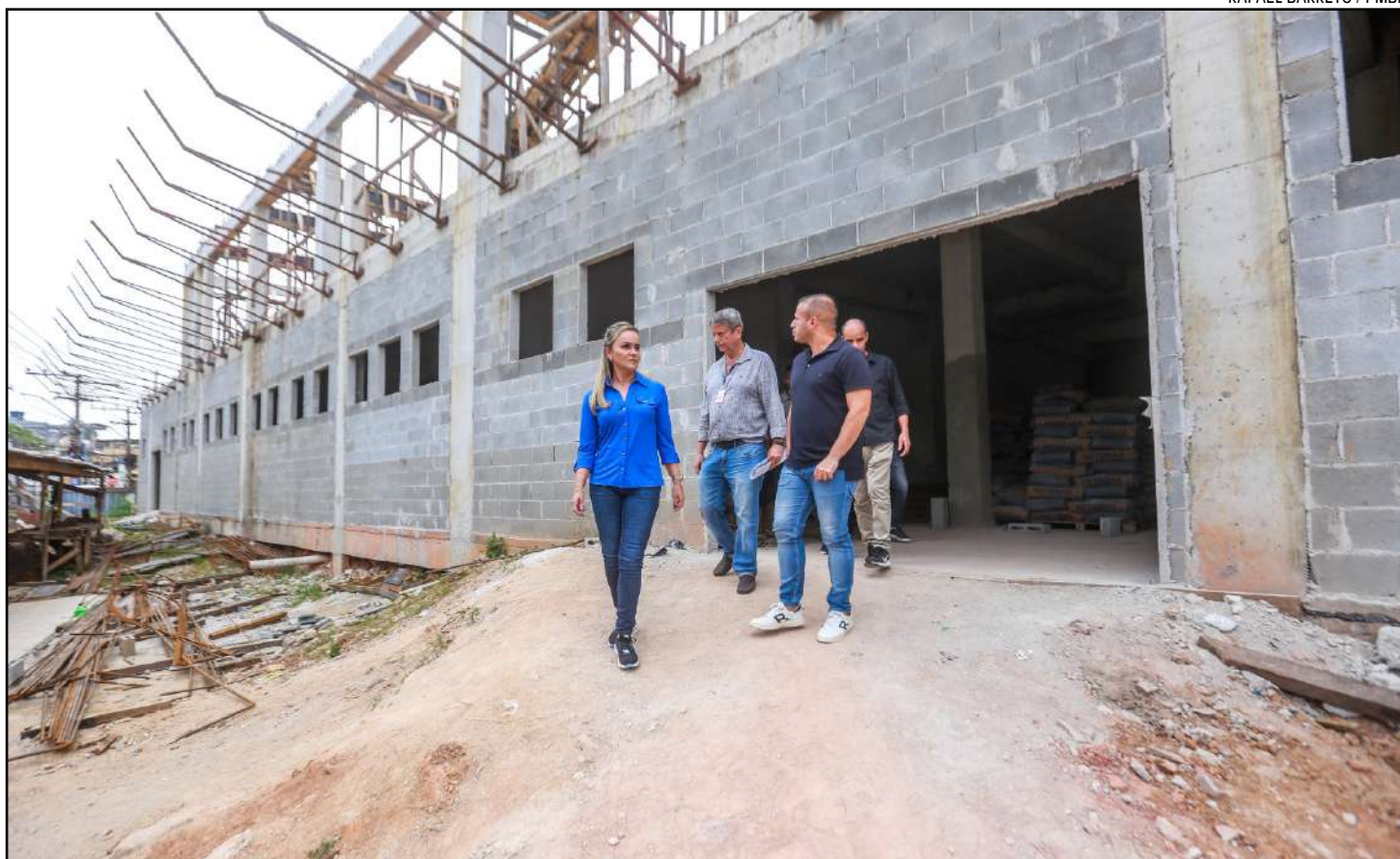
No Hospital Municipal, Daniela do Waguinho e Matheus Carneiro verificaram o andamento das obras de ampliação da unidade
