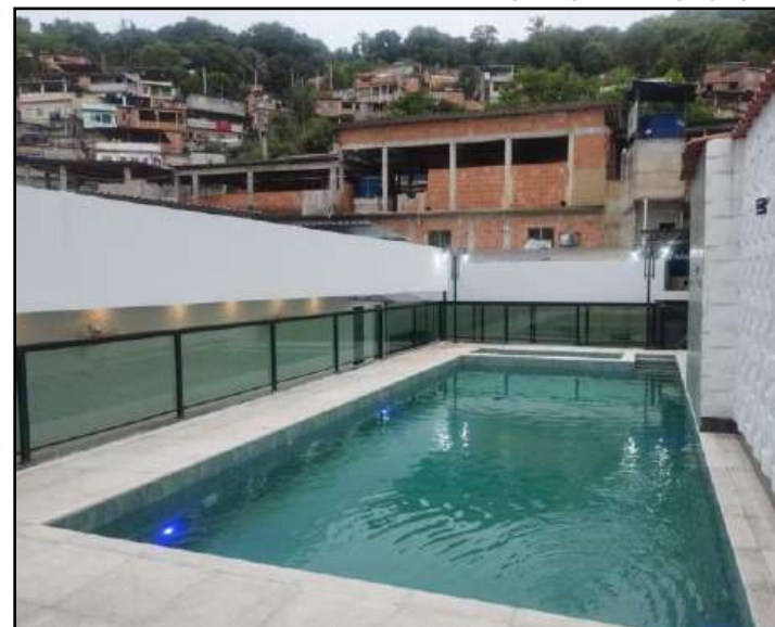
O imóvel parecia estar ainda em obras e tem acabamento de luxo
