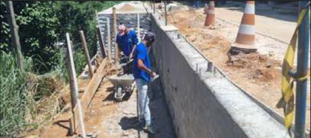
Por meio do Furban-VR, regiões do bairro estão recebendo serviços de contenção de encostas, drenagem pluvial e reparos, pinturas, entre outros
