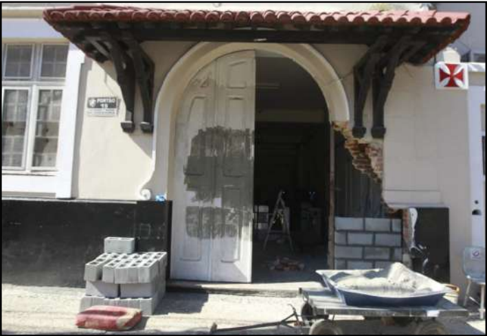
Muro já está sendo reconstruído após acidente
