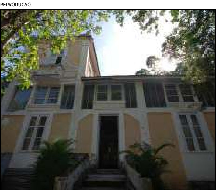
Obras têm prazo de 330 dias e investimento de R$ 5 milhões
