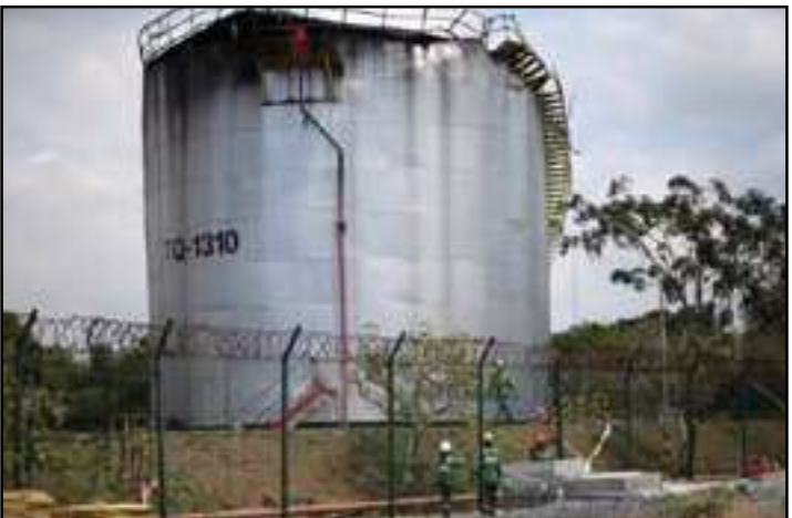
A explosão aconteceu em um tanque da Vibra
