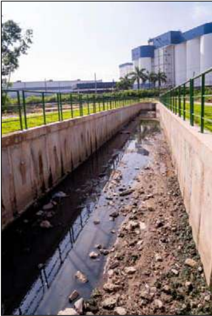
Obras ampliaram a capacidade de drenagem da região
