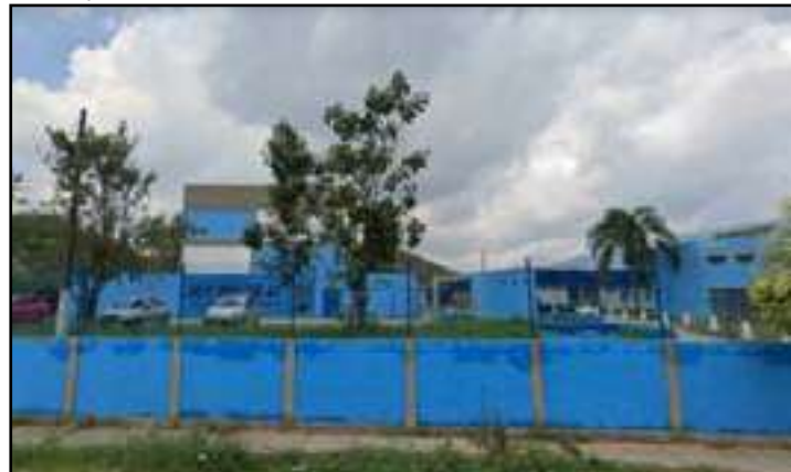
Vandalismo deixou Ciep 383 Maximo Gork sem energia
