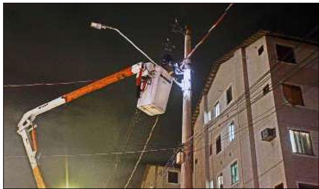
Município ultrapassa 60 mil luminárias instaladas
