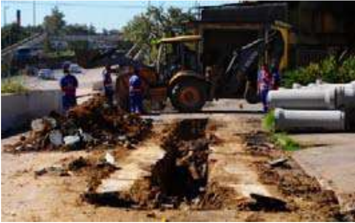
CODENI substitui tubulação danificada em Comendador Soares
