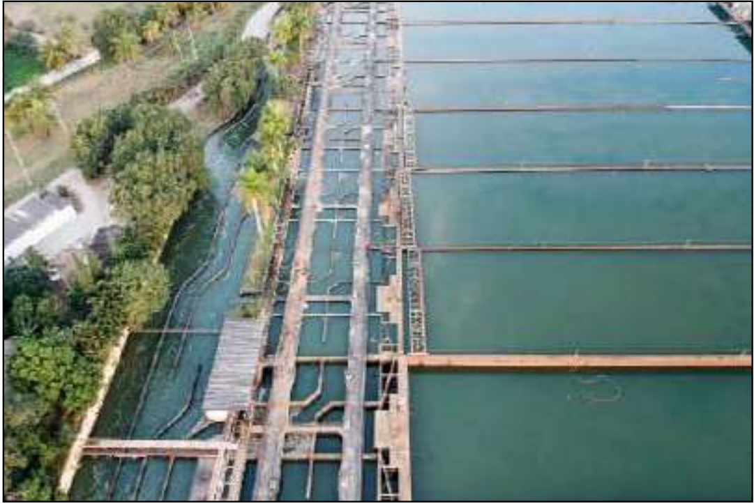
Equipamento da ETA Guandu apresentou problemas que comprometeu o abastecimento nas duas regiões
