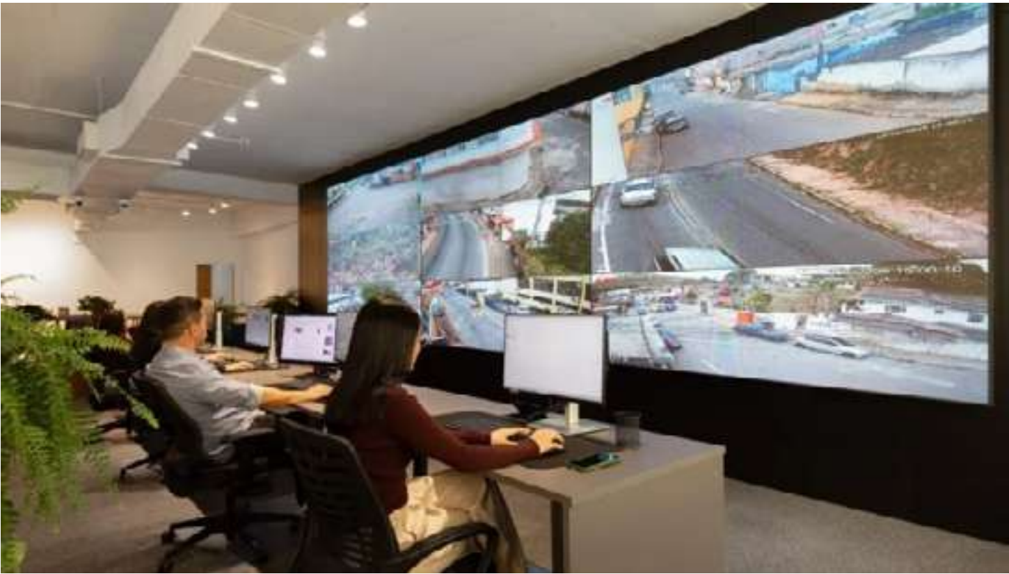
A Central Integrada de Monitoramento da Essencio Tecnologia Ambiental
