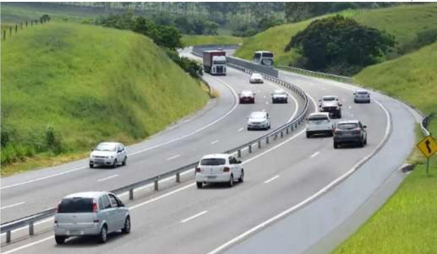
CCR diz não ter autorização para intervenções na Via Lagos
