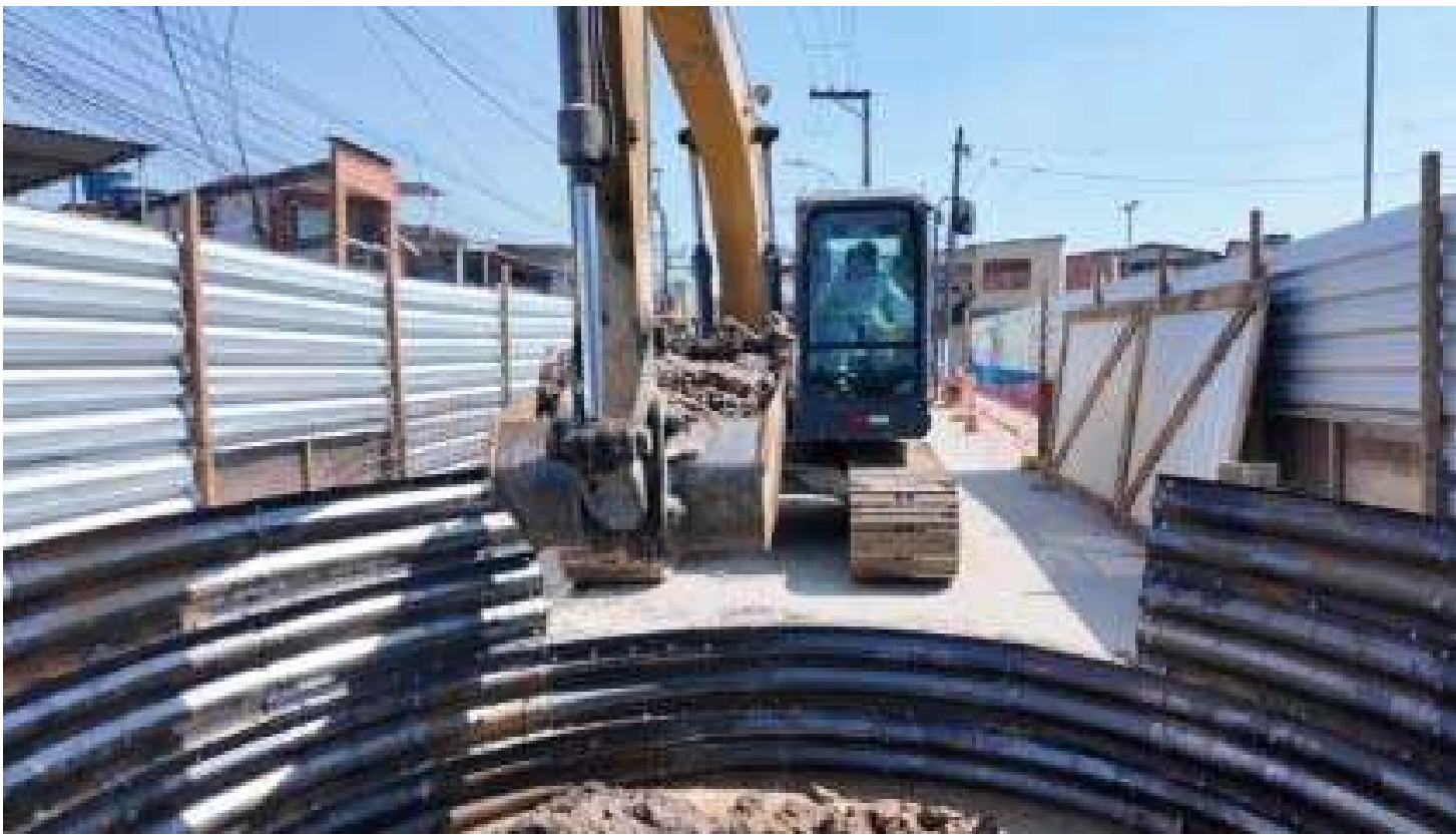
Entre as intervenções previstas está a implantação de 22 quilômetros de rede subterrânea
