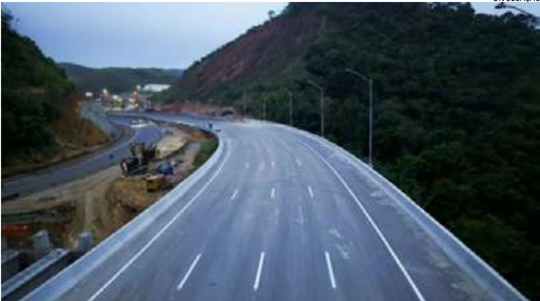
Estruturas serão usadas temporariamente por motoristas no sentido São Paulo
