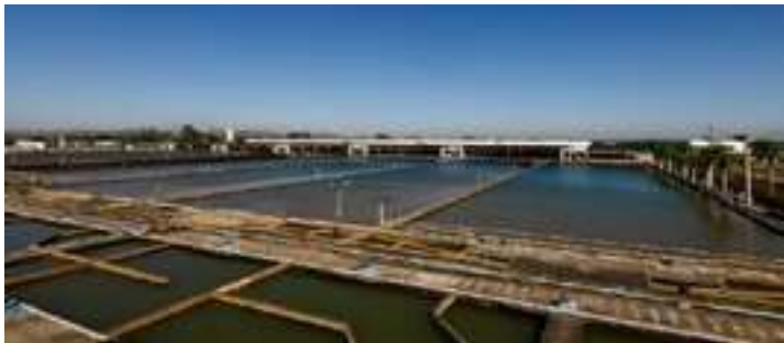
Estação de tratamento de água opera com 73% da capacidade
