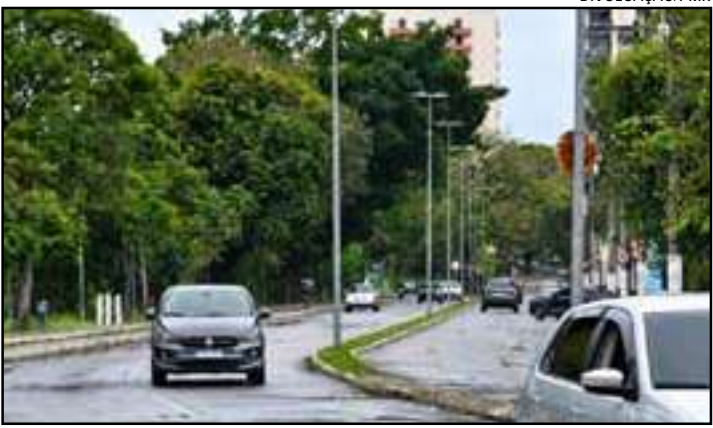
Intervenção substituiu a antiga rede de 600 milímetros por galerias de 2.000 milímetros
