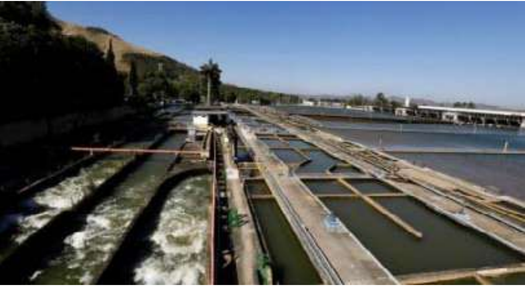
Intervenção afeta o abastecimento de cerca de 2 milhões de pessoas
